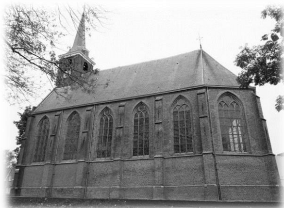
Dankzij vele restauraties die de afgelopen decennia zijn uitgevoerd, verkeert de Dorpskerk anno 2019 in een uitstekende bouwkundige staat.
